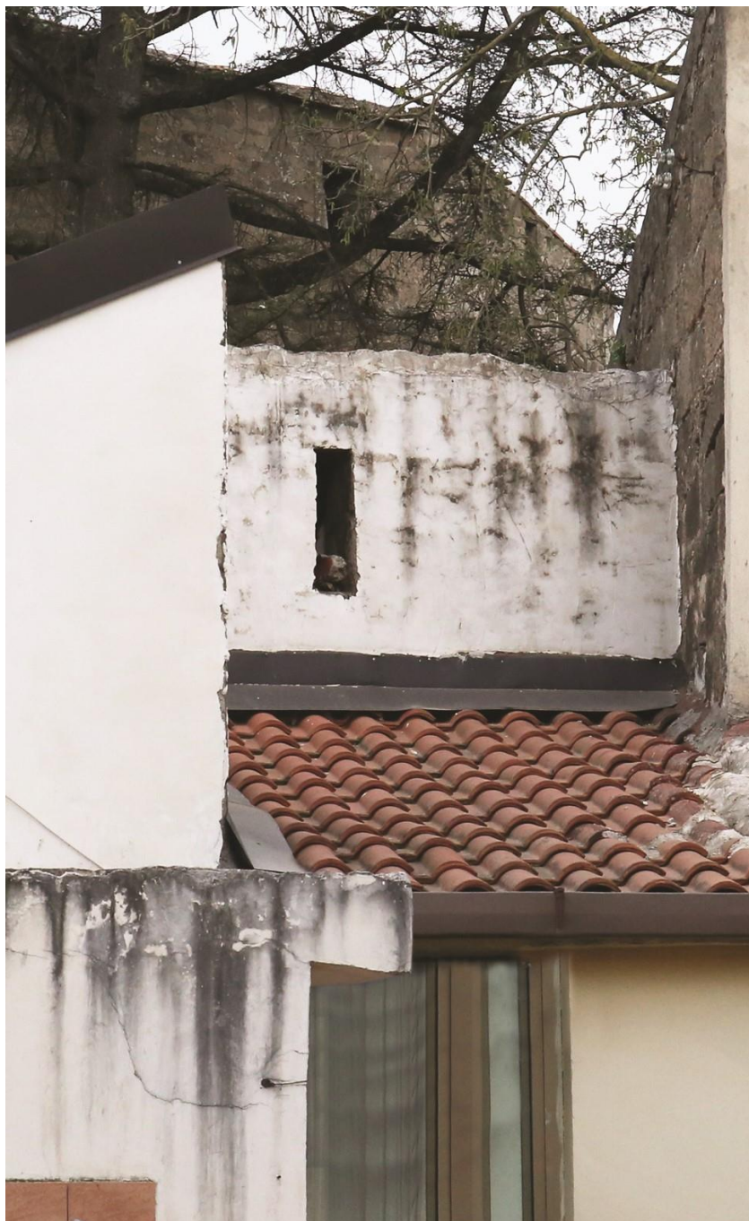
凝灰石牆的 Intostukcem 外牆加工
