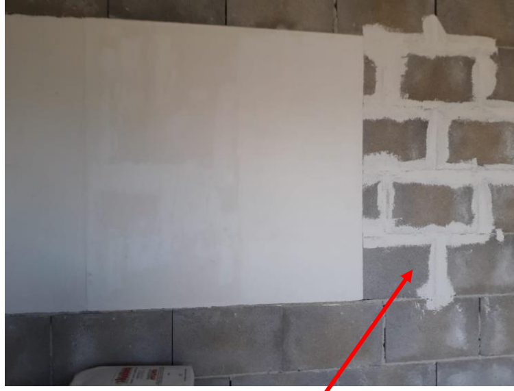
閉合接縫和撤去混凝土磚
