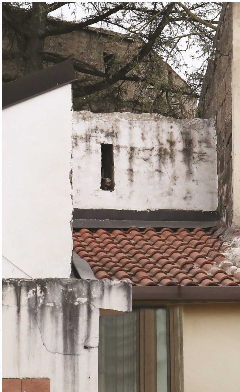
凝灰石牆的 Intostukcem 外牆加工
