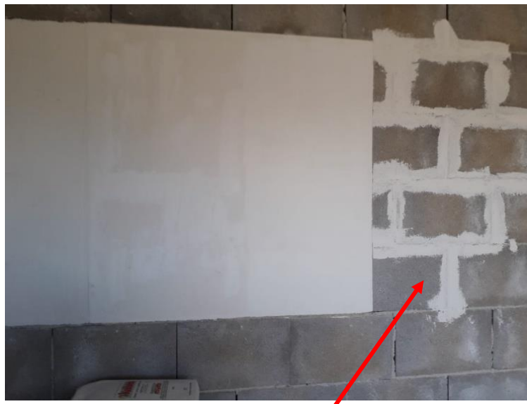
Jointoiement et ratissage sur blocs de béton
