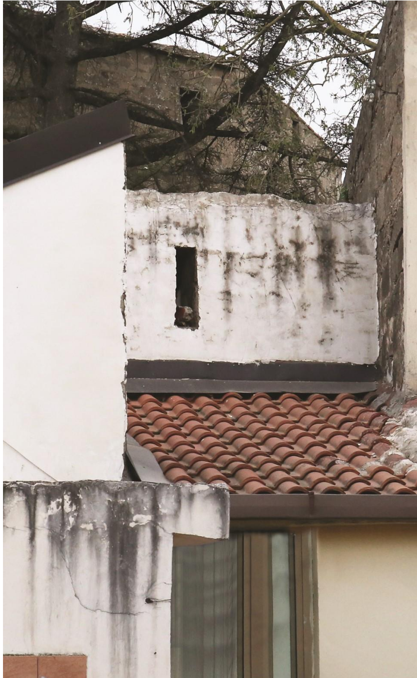
Application extérieure d'Intostukcem sur murs en pierre de tuf
