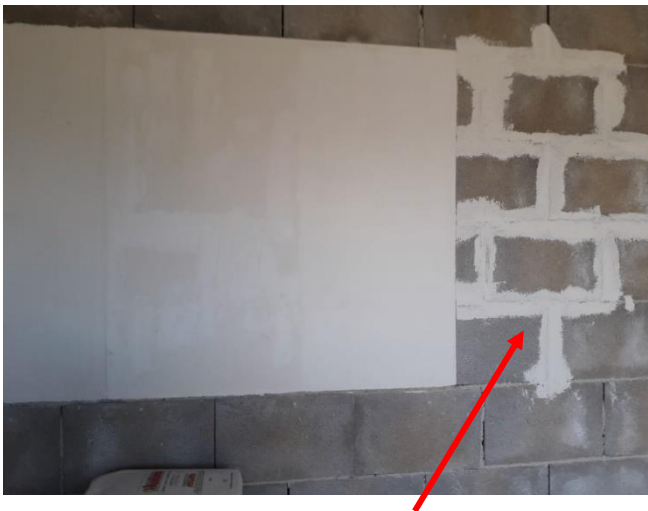
Remplissage des joints et ratissage sur blocs de béton
