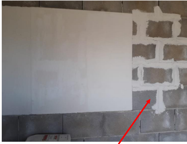
Chiusura di fughe e rasatura su mattoni in cemento
